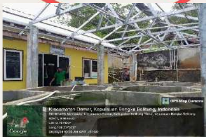
Pendampingan, pengecekan Rancang bangun, UPT. Balai Perikanan Budidaya, Mempaya
