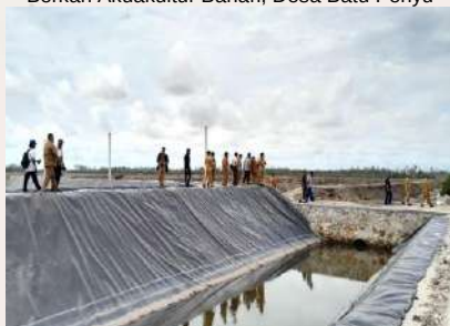
Kondisi Saluran Outlet. PT. Berkah Akuakultur Bahari, Desa Batu Penyuh
